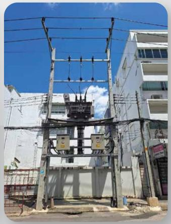
**DUCT BANK FOR UNDERGROUND POWER CABLE 22 kV SUBSTATION**
